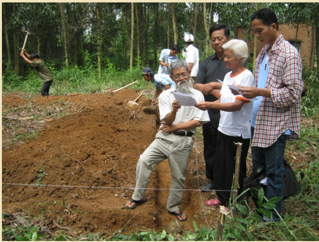
Lễ đặt viên đá đầu tiên và khởi công xây dựng nhà Uma
